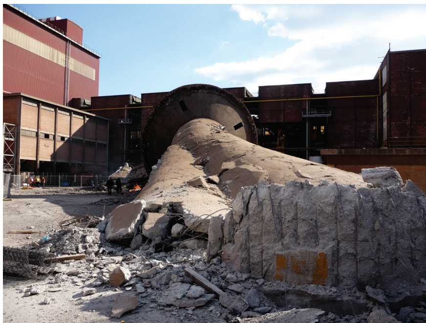
FIG. 1 – Fondazione Ansaldo, Archivio fotografico Sperati. Demolizione piezometrica di aree Ilva, Genova Cornigliano, 20 marzo 2009.
